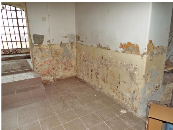
A vakolati károk jól láthatóak a belső térben.
