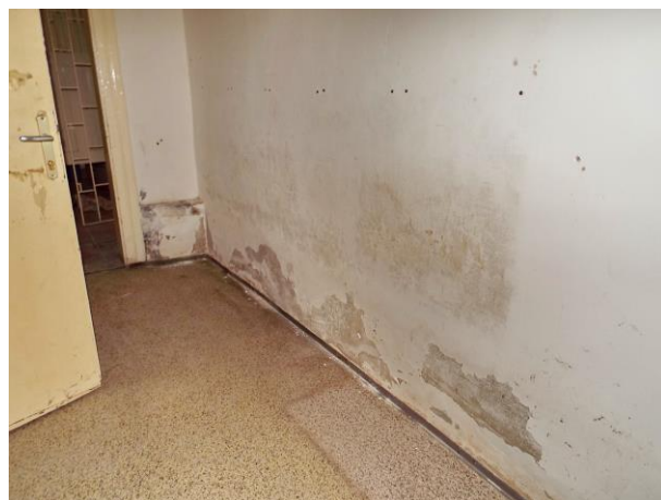
A nedvességfelszívódás megakadályozására utólagos szigetelés szükséges. Azonban a padló alatt sincs szigetelés, ezért ott is nedvesség elleni szigetelést és hőszigetelést kell készíteni.
