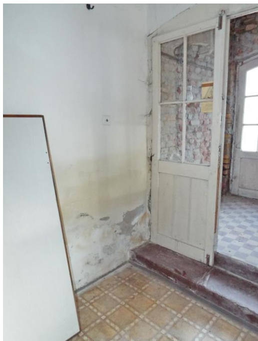
A nedvességfelszívódás megakadályozására utólagos szigetelés szükséges. Azonban a padló alatt sincs szigetelés, ezért ott is nedvesség elleni szigetelést és hőszigetelést kell készíteni.
