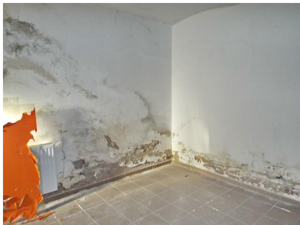
A vakolati károk jól láthatóak a belső térben.
